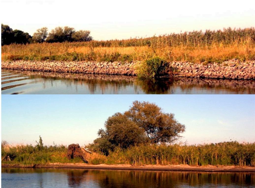
Abbildung 3: Maßnahmenbeispiel – Uferabschnitt mit Deckwerk (oben) und nach der Entsigelung (unten).
